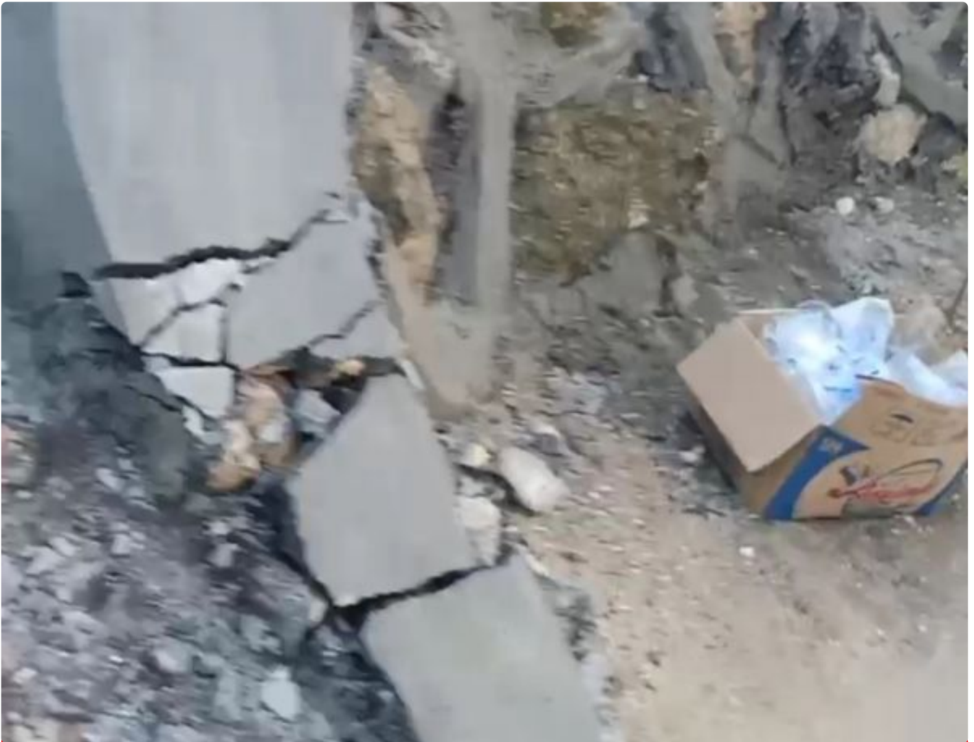
Salah satu bagian Plengsengan yang mulai hancur
